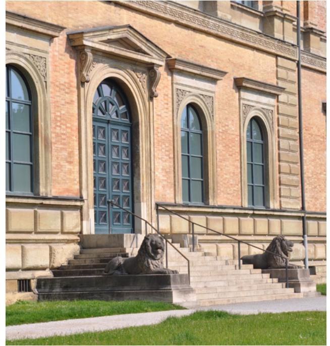
„Klenzetur“ - ursprünglicher Eingang
