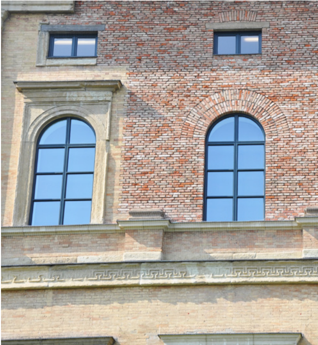
Detail: Reparatur der Fassade mit Trümmersteinen
