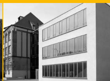
Adam Kraft Ganztagschule mit Schüler-/ Jugendtreff, Nürnberg – Almoshof bau3 architekten böhmér & gumbrecht partnerschaft, Petra Elfriede Gumbrecht, Maria Böhmér, Nürnberg Foto: Martin Lange
