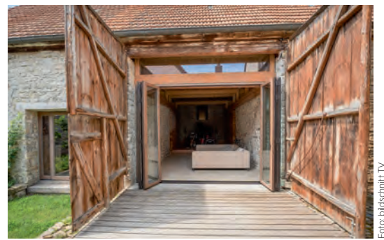
Einziehen statt abreißen – Ausbau einer historischen Scheune zu Wohnzwecken“, Lukas Neuner, Eisenheim
