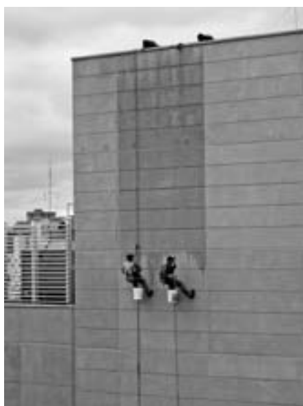
Funktioniert auch ohne Gerüst
