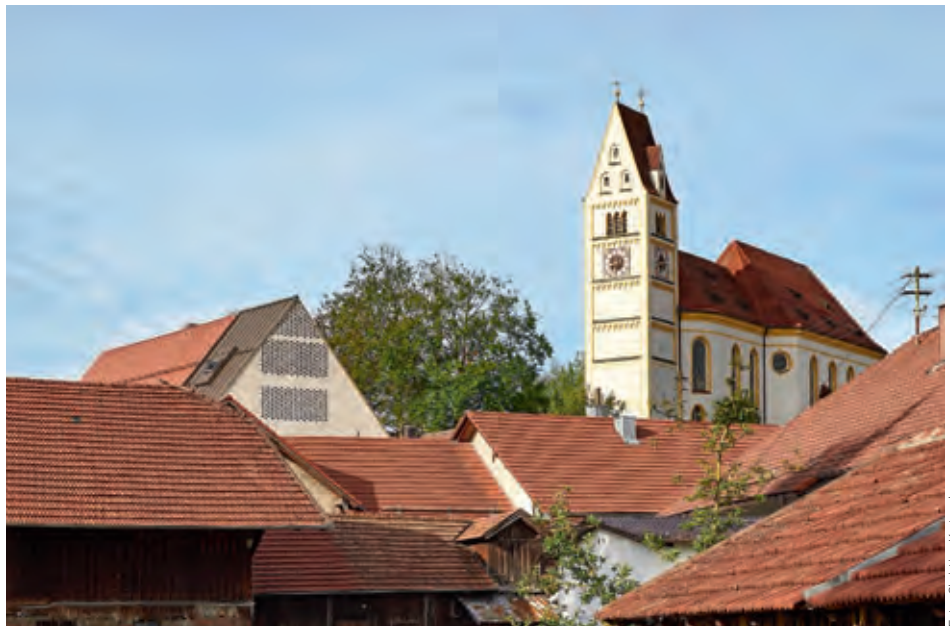
Preis für Baukultur: „Neue Dorfmitte Denklingen – Gasthof Hirsch – Umnutzung zum Rathaus und Bürgersaal“, Architektur: Sunder-Plassmann Architekten Stadtplaner, Utting/A Landschaftsarchitektur: Terra Nova Landschaftsarchitekten, München, Bauherrin: Gemeinde Denklingen
