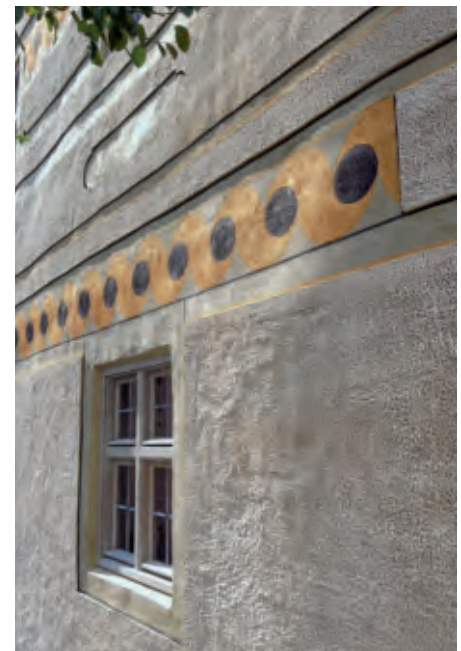
Jurahaushaus Dietfurt, Architektur: Kühnlein Architektur
